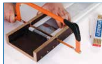
Zuschneiden der Profile auf die benötigte Länge.
