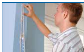
Ausmessen der Türöffnung (Breite und Höhe).
